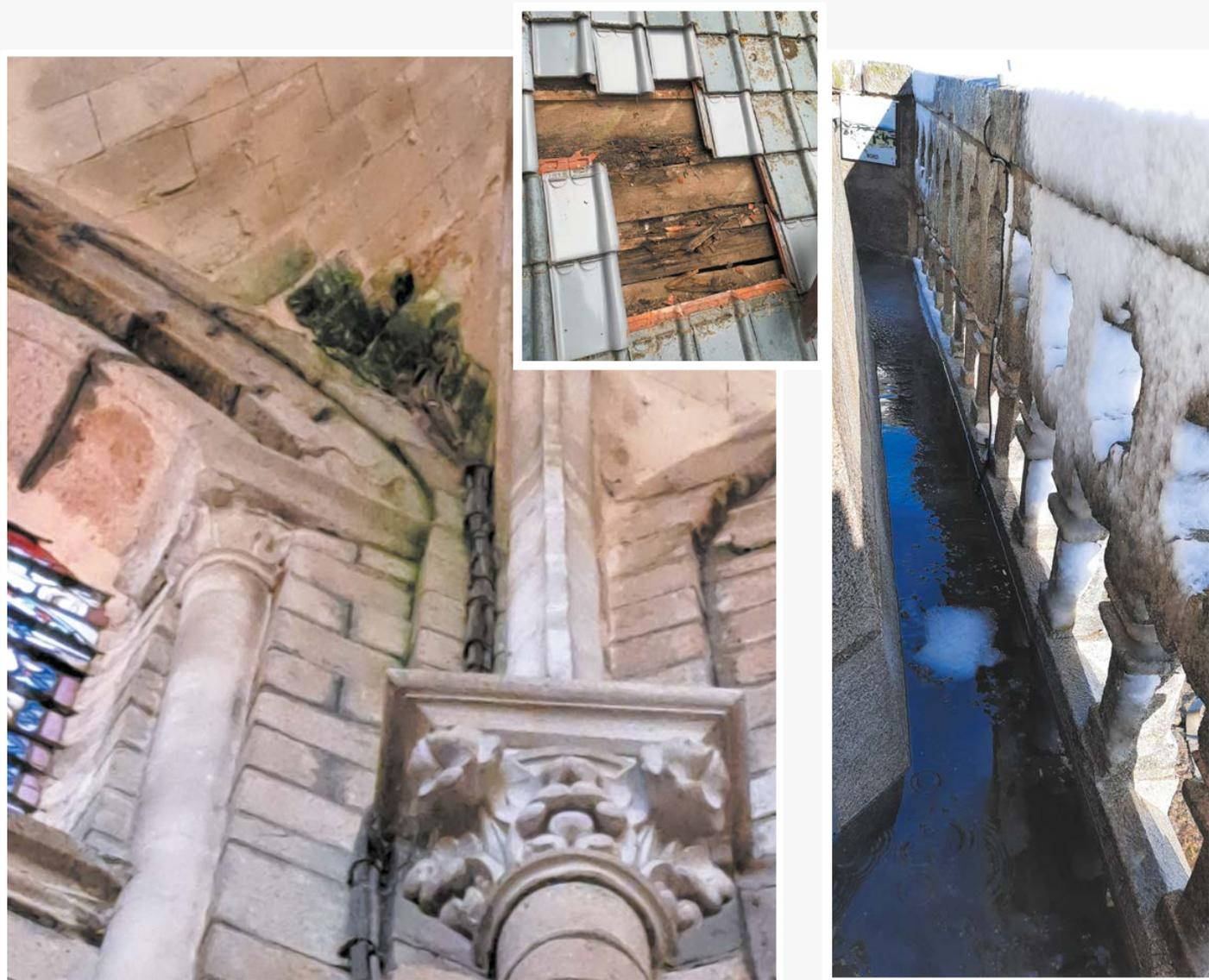
Les photographies fournissent une illustration claire des problèmes à résoudre. Tout d'abord, il est impératif d'évacuer l'eau qui stagne sur le balcon du clocher. Cette accumulation d'eau constitue une menace directe pour la structure, en accélérant les phénomènes de dégradation. Par ailleurs, il est crucial de colmater les fuites observées à différents endroits stratégiques : les moraines, les soudures des chéneaux, ainsi que la couverture, qui montrent des signes évidents d'usure.
